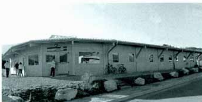
Une structure en bois massif pour ce bâtiment bioclimatique et basse consommation
